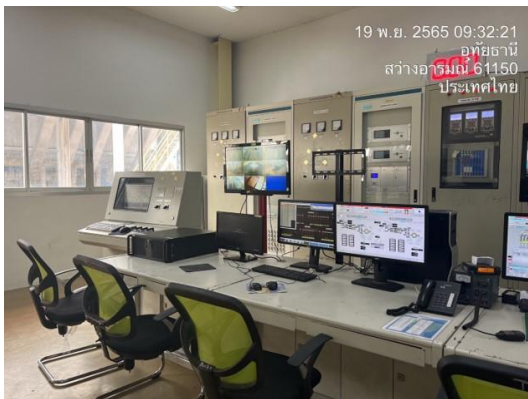
ภาพที่ 86 ระบบ DCS และเจ้าหน้าที่ควบคุมการทำงานของหม้อไอน้ำ กังหันไอน้ำและเครื่องกำเนิดไฟฟ้า
