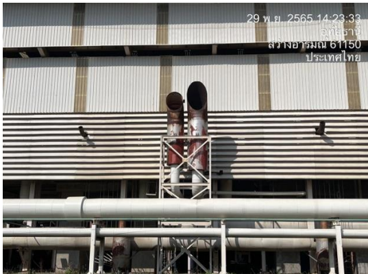
ภาพที่ 46 การติดตั้ง Silencer บริเวณ Stream Turbine
