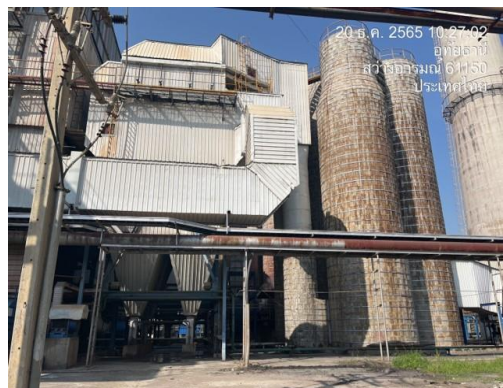
ภาพที่ 15 ระบบบำบัดมลพิษอากาศ Wet Scrubber และ Multicyclone
