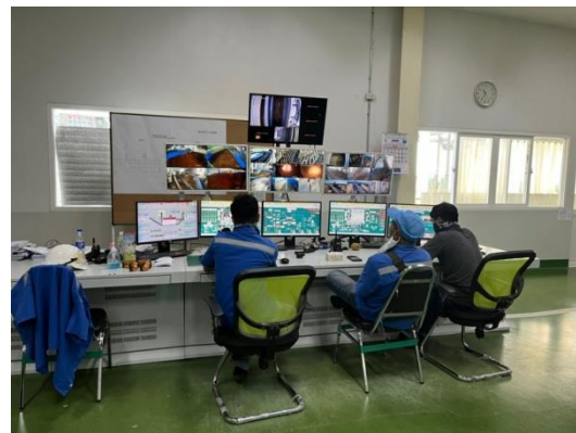
ภาพที่ 86 ระบบ DCS และเจ้าหน้าที่ควบคุมการทำงานของหม้อไอน้ำ กังหันไอน้ำและเครื่องกำเนิดไฟฟ้า
